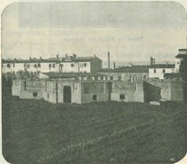
Idem — Stato dei lavori (istantanea da tergo).
